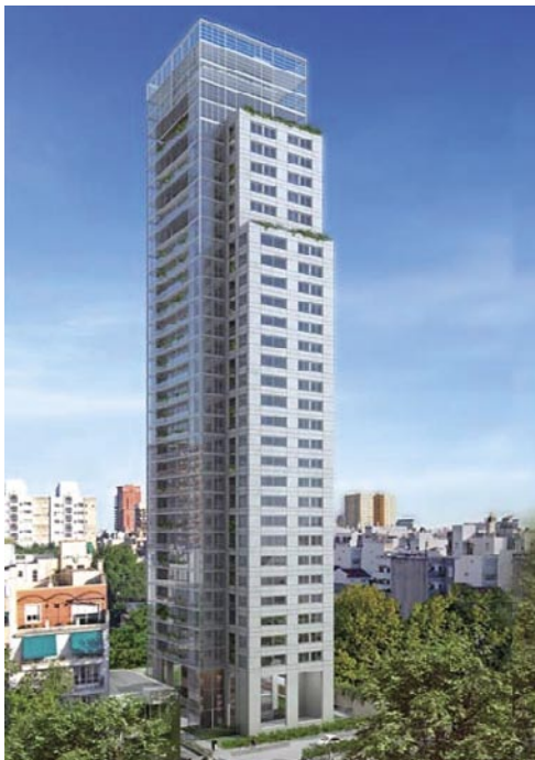
Torre Palermo Uno. Sistema utilizado: Línea Mediterránea y Frame Customizado. Fabricación y montaje: Teksigler S.A.
