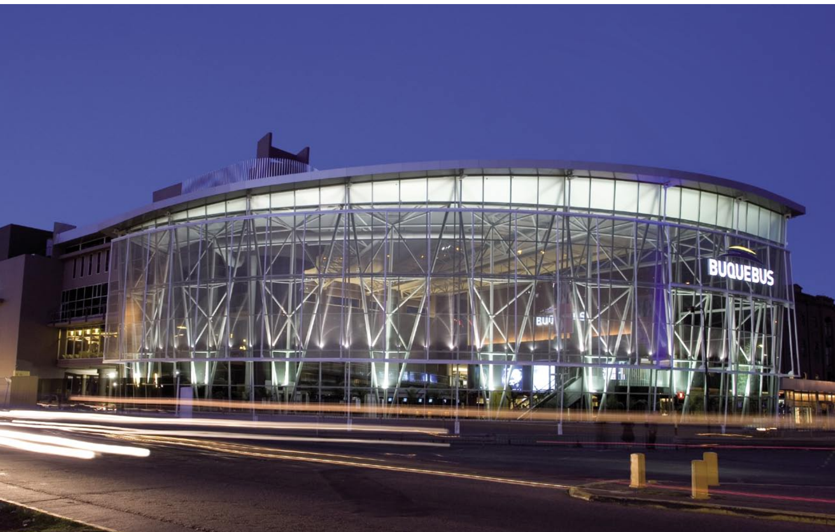
Nueva Terminal de Buquebus. Sistema utilizado: Frente Integral. Fabricación y montaje: Gut Metal S.R.L.
